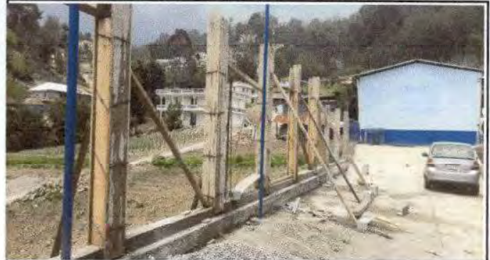
Foto 2: Instalación de las columnas para el soporte de los barrotes
