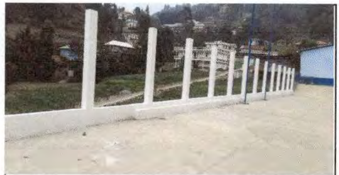
Foto 6. Vista general de terminado del repello de la solera de humedad y las columnas enfrente de la escuela.
