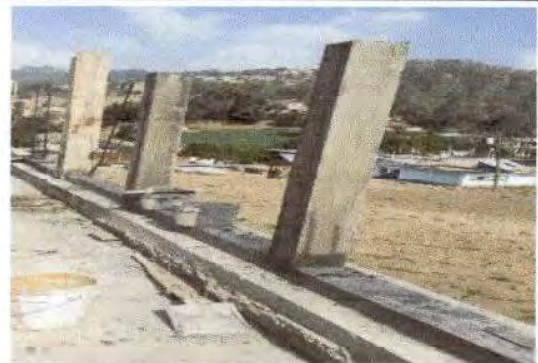
Foto 4: Instalación de columnas para el soporte de los barrotes enfrente de la escuela.
