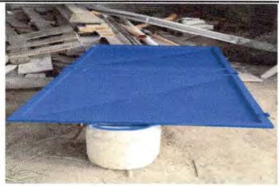
Foto 2: Pintando la estructura de metal de la puerta.
