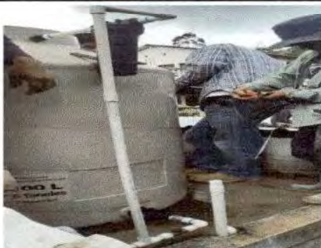
Foto 3: Verificando y colocando los diferentes materiales del depósito de agua.
