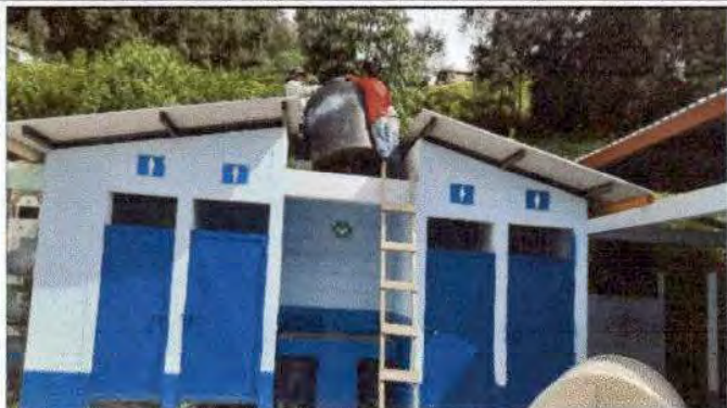
Foto1: Desconectando el depósito de agua para sustituirlo.
