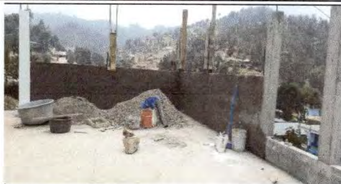
Foto 2: fundición de columnas para sostener los barrotes.
