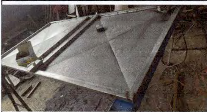
Foto 1: Lijando la estructura de metal de la puerta para poder pintar.
