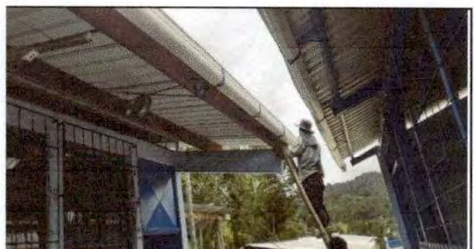
Foto 6. verificando el desnivel de los canales para que el agua pueda correr con facilidad.
