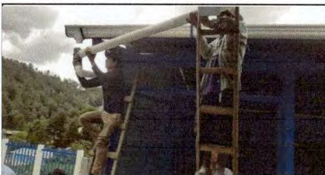
Foto 5: instalación de los canales de agua en las aulas de la escuela.
