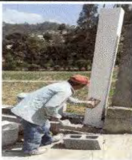
Foto 5: iniciando el repello de las columnas con crestruco para el tallado final.
