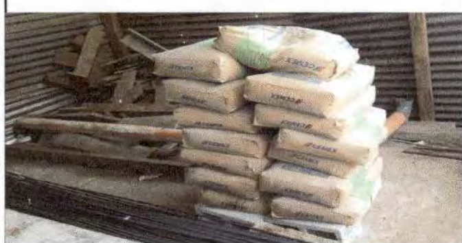
Foto 3: Materiales para iniciar los trabajos en la Escuela Oficial Rural Mixta.
