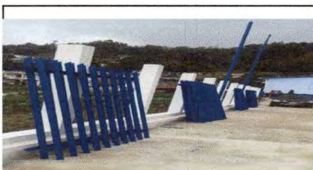
Foto 5. distribullendo los barrotes para posteriormente colocarlos.
