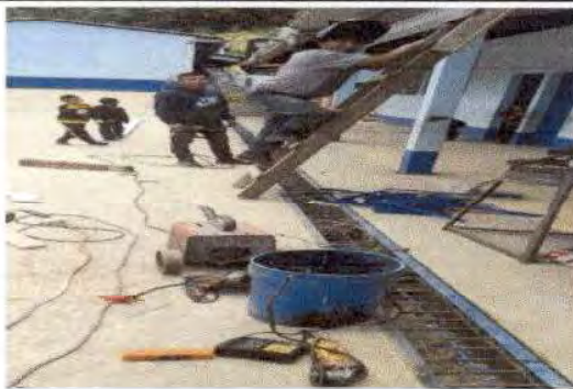
Foto 3: Instalacion de soportes y/o pescantes en las aulas de la escuela.
