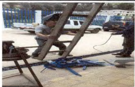
Foto 4: Instalando los soportes y/o pescantes para sostener los canales de agua.
