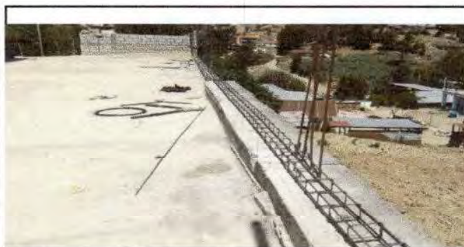
Foto 5: instalación de hierro para la solera de humedad.
