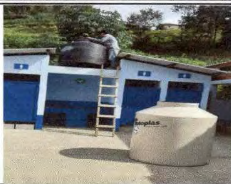
Foto 2: Bajando el depósito de agua para poder colocar el depósito nuevo de 1,100 litros.
