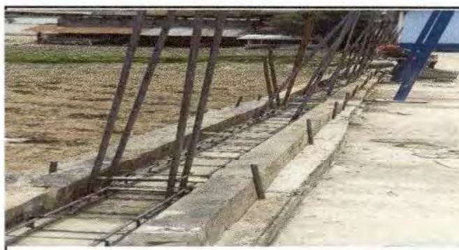
Foto 6. alistando el espacio para fundir la solera de humedad de soporte de las columnas.
