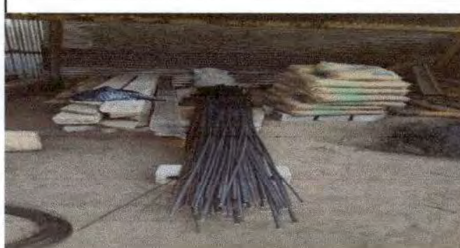
Foto 4: Materiales para realizar los trabajos en la Escuela Oficial Rural Mixta.
