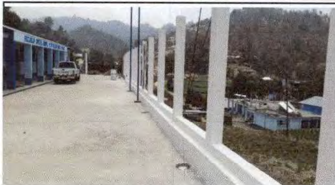
Foto 1: se finalizo de repellar las columnas de 20 por 20 centímetros con crestuco.
