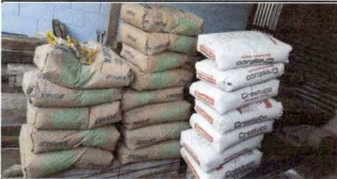
Foto 3: materiales para finalizar los trabajos y repello final de la solera de humedad y las columnas.
