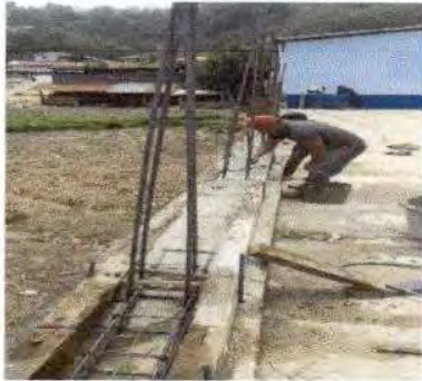
Foto1: Fundiendo la solera de humedad de 10 por 20 centímetros
