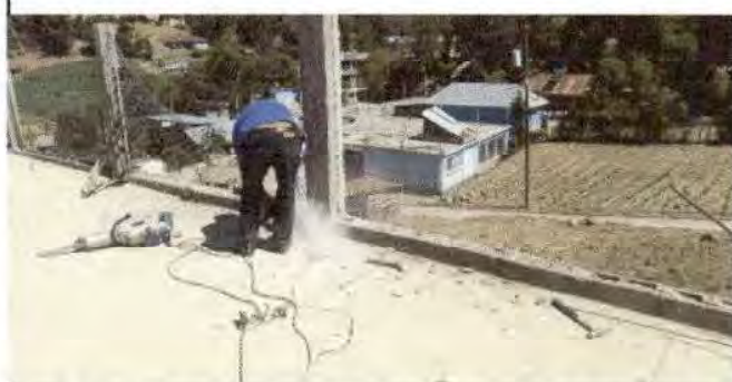
Foto 2: Dejando libre el espacio e iniciando los trabajos de limpieza para iniciar la solera de humedad.
