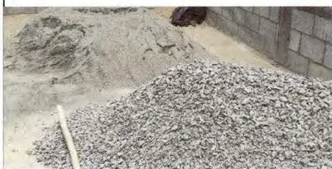
Foto1: Materiales para iniciar los trabajos de solera de humedad y columnas para el soporte de los barros.
