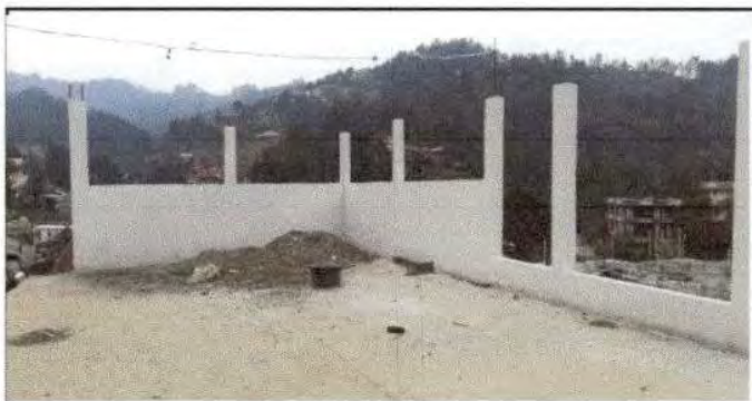
Foto 3: repello de de columnas utilizando crestuco .
